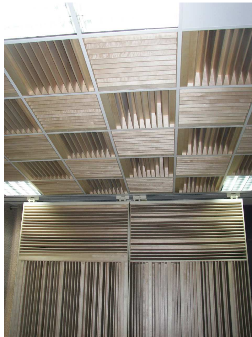
Rys. 19. Sufitowe ustroje rozpraszające dźwięk – przykładowa realizacja (reżysernia w Rozgłośni Polskiego Radia w Bydgoszczy)
